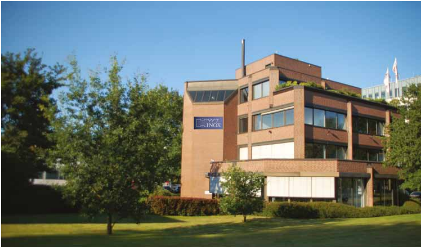
Das Bürogebäude der HW-INOX GmbH.
