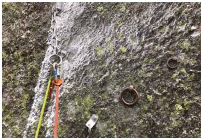
Kettenstände mit Ring oder Karabiner dienen im frisch sanierten und erweiterten Klettergarten am Gotthardmassiv dazu, am Ende einer Route, das Seil umzuleiten und den Kletterer wieder abzulassen. Fotos: JDAV Landesverband Baden-Württemberg
