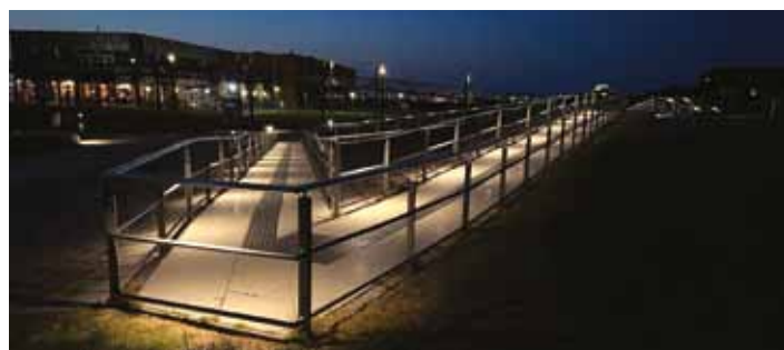
Die Geländer auf dem weitläufigen „Deck“ in Norddeich hat die OTG elektropoliert – die Bearbeitung schützt vor Korrosion. Foto: OTH/OTG
