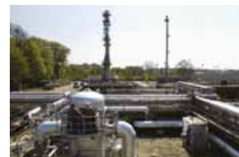
Arbeiten an der Verdichterstation Visbek in Süddoldenburg. Foto: Exxon Mobile
